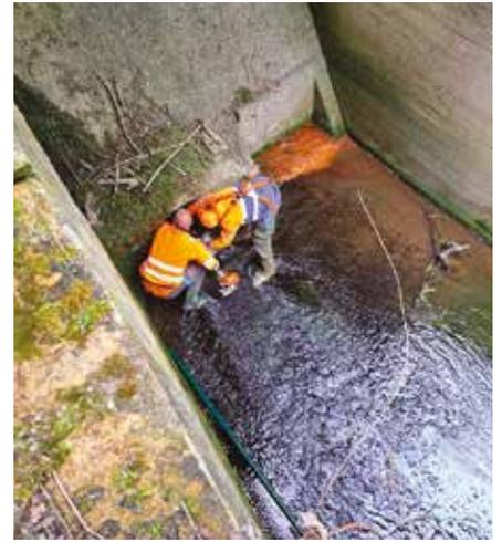
Nos ouvriers ont effectué une opération difficile pour déboucher un tuyau de vidange à la digue du lac. Des branches entremêlées réduisaient la capacité d'évacuation. Un travail bien nécessaire pour limiter le risque d'inondation en amont. Il était important d'attendre un débit plus faible pour intervenir. Merci Ryan, André-Marie et Freddy pour votre professionnalisme.
